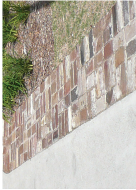
BRICK PAVING EDGE
